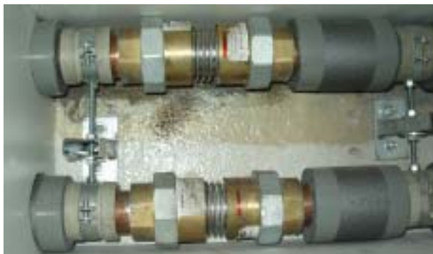
Rys. 3.14.1. Kompensator typu mieszkowego \varnothing 54 ze stali kwasoodpornej z półrubunkami
