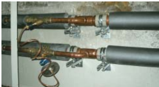
Rys. 3.16.1 Punkt stały z odejściem na trójniku
