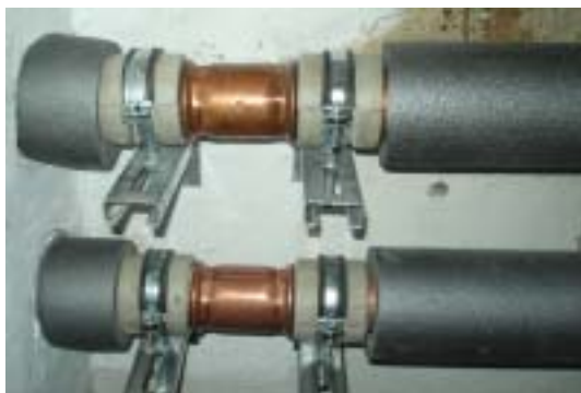
Rys. 3.17.1. Prawidłowy punkt stały w technice zaprasowywanej
